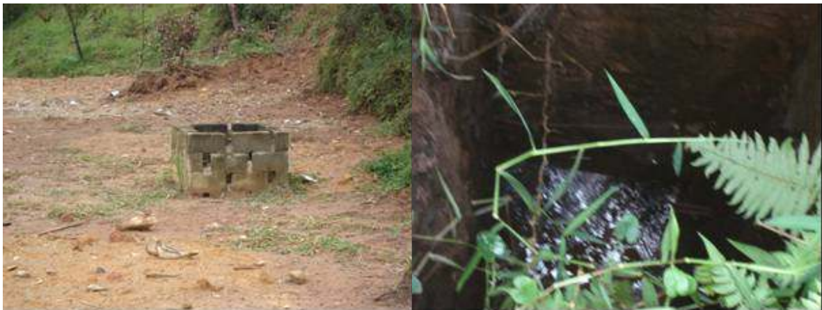
Foto 11 Tanque de aguas lluvias
