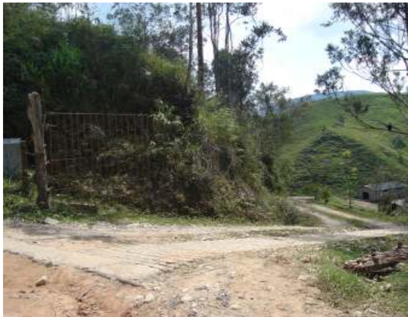
Foto 9 Vía de acceso al Relleno Sanitario
