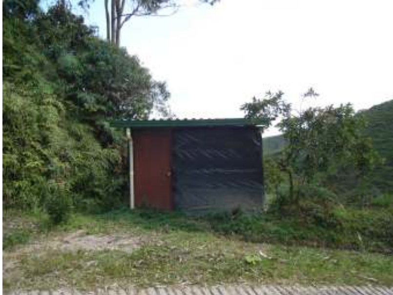
Foto 10 Caseta de Almacenamiento de Residuos Hospitalarios
